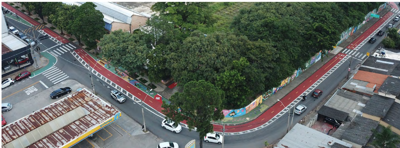
Figura F-20 | Rua Lacerda Franco pós-intervenção (Jundiaí)
