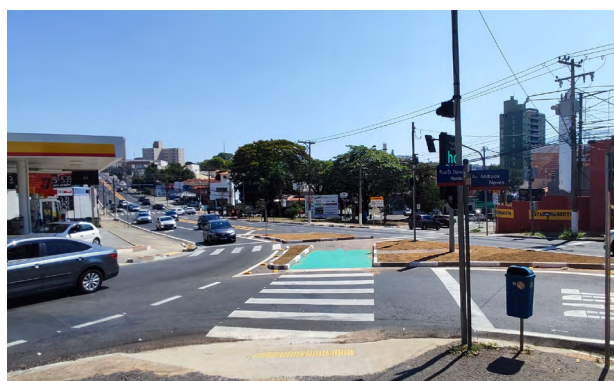
Figura E-21 | Cruzamento da Av. Andrade Neves x Rua Dr. Otávio Mendes após a intervenção (Campinas)
