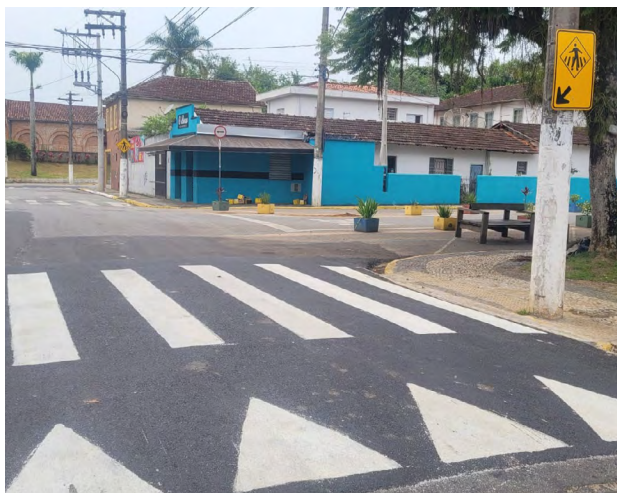
Figura G-25 | Travessia elevada pós-intervenção (Registro)
