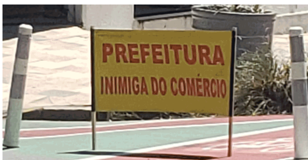
Figura F-11 | Início da implantação da sinalização horizontal - Rua Lacerda Franco (Jundiaí, 2/12/2022)
