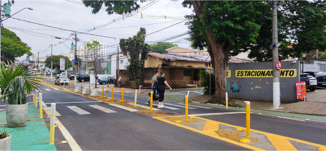
Figura E-26 | Travessia na faixa de pedestres em frente aos estacionamentos - Fase 2 (Campinas)
