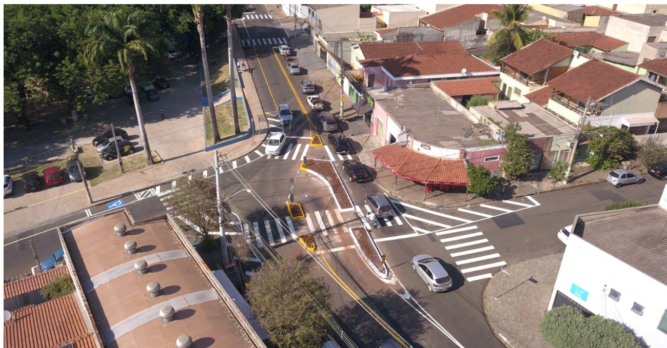
Figura H-10 | Intervenção do segundo piloto no entorno da EMEF Domingos Adilson Canesin (Ribeirão Preto)
