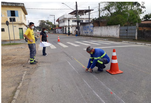
Figura G-14 | Demarcação da ciclofaixa (Registro)
