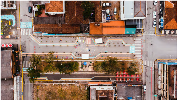
Figura G-7 | Boulevard Beira Rio, pós-intervenção (Registro)
