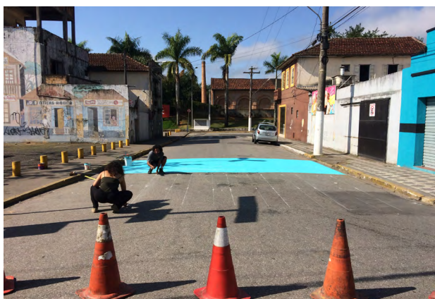
Figura G-13 | Demarcação do piso Zona 30 (Registro)
