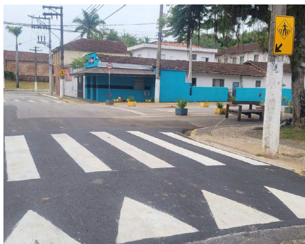
Figura G-25 | Travessia elevada pós-intervenção (Registro)
