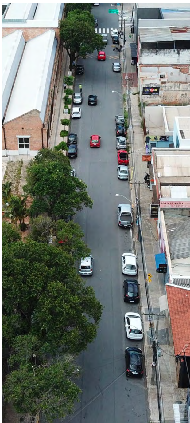
Figura F-6 | Área antes da intervenção
