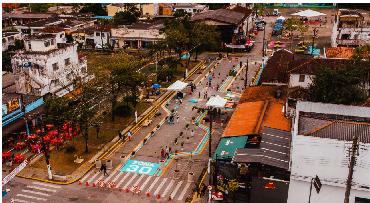
Figura G-27 | Boulevard Beira Rio pós-intervenção (Registro)
